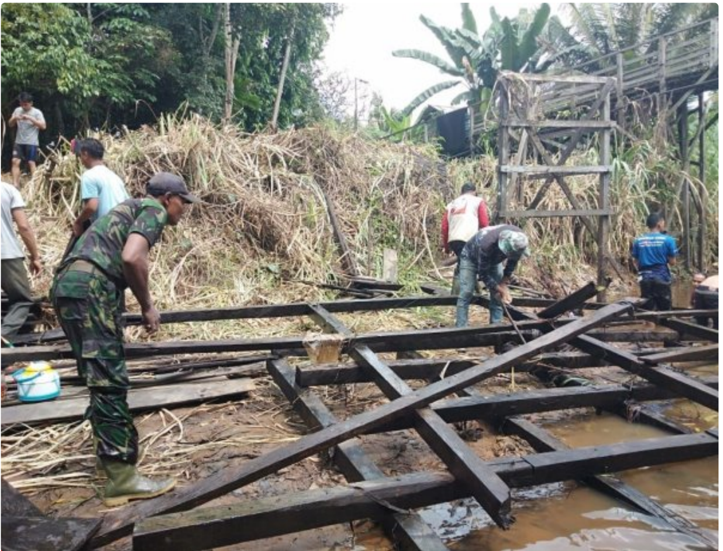
Cegah Banjir dan Penyebaran Penyakit, Koramil 1001-04/Batumandi Lakukan Kerja Bakti Bersihkan Saluran Sungai
